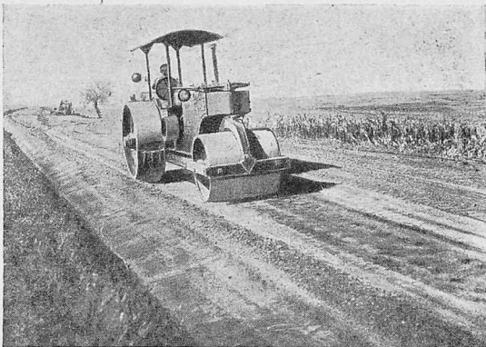
Каток советского производства на строительстве Карта—Кач Игринской дороги (Катский район)
